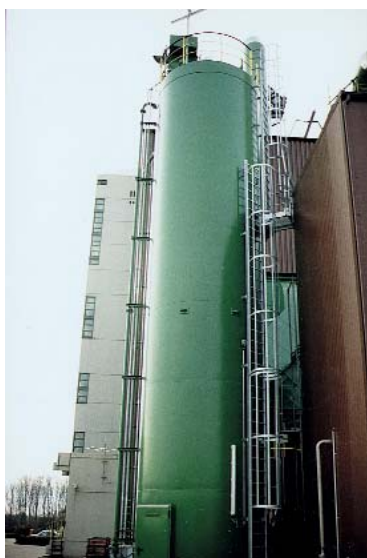
Anläggning för kalkdosering i ett avloppsreningsverk.
